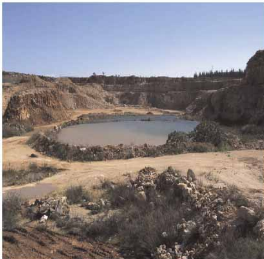
Рис. 10. Фото дождеприемника на месте старого карьера для пополнения запасов воды
