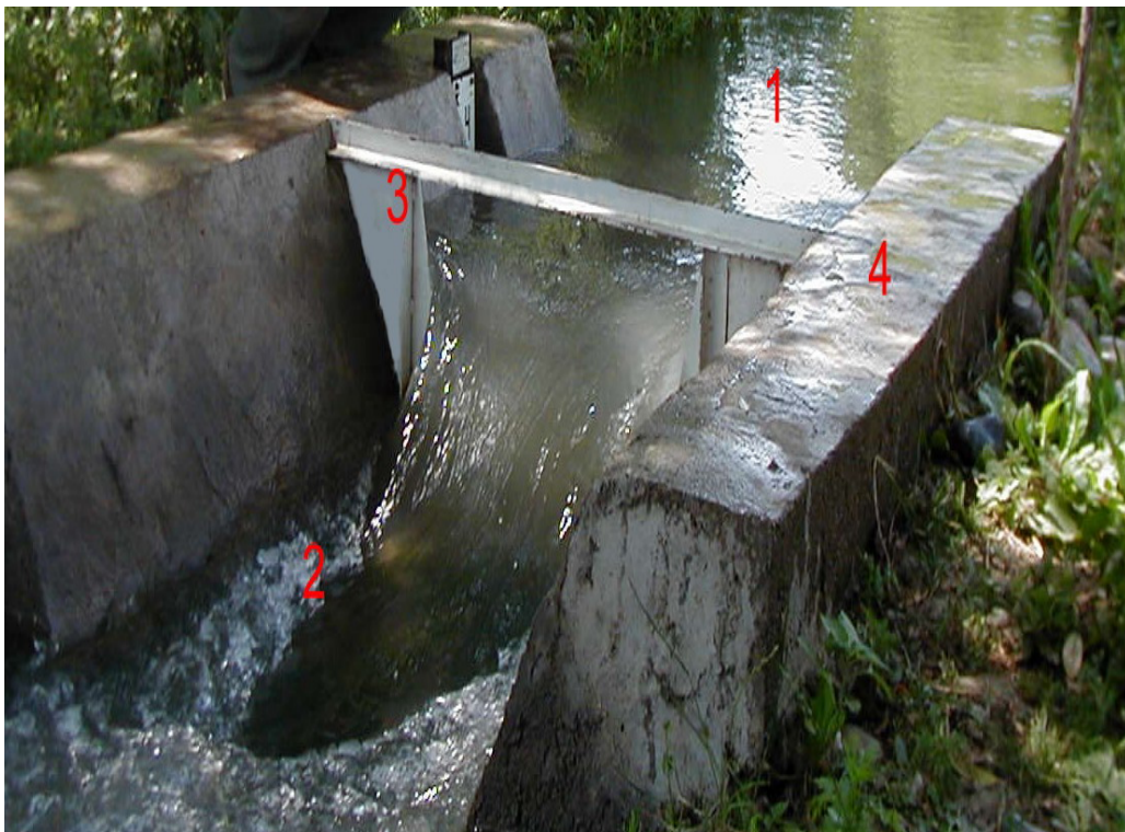
Рис.2. Водослив Чиполетти (вид с нижнего бьефа): 1- подводящий участок; 2 - отводящий участок; 3 - водослив; 4 - крепление бермы.
