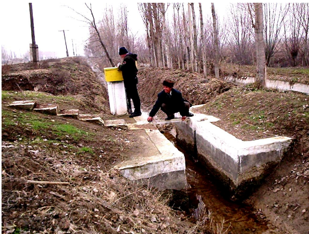
Рис. 7. Гидрометрический пост типа «фиксированное русло».
